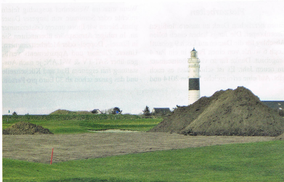
Umbauarbeiten auf der Driving Range.
